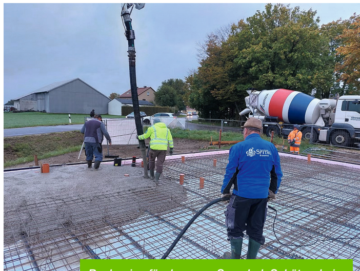
Baubeginn für das neue Scambah Schützenheim
